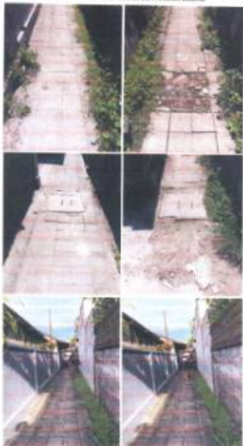
PERUBAHAN JALAN DESA DI GAWAU KIRINO-GULU VI DUSUN BELONG
