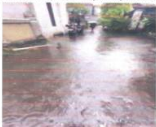
Pembuatan Sumur Resapan di Jl. Dadas Suren IV menuju Villa Dewi-Dewi
