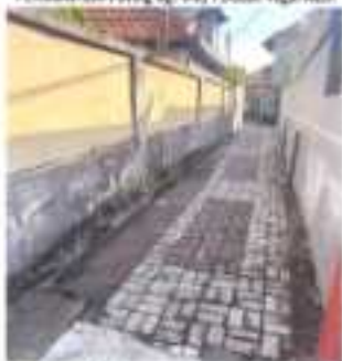
Pemeliharaan Paving Dg. VIB/1 Dusun Tegal Asih
