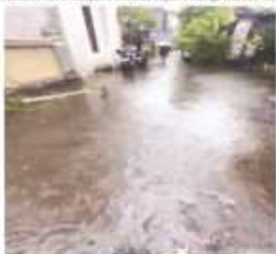
Pembuatan Turun Air Resapan di Jl. Dutaan Bangsa IV menuju Villa Dewi Dewi
